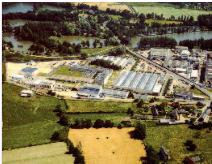
Vue du Cerdato sur le site Arkema (Serquigny)
